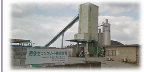
アサノ有明生コン(株) 北部工場
