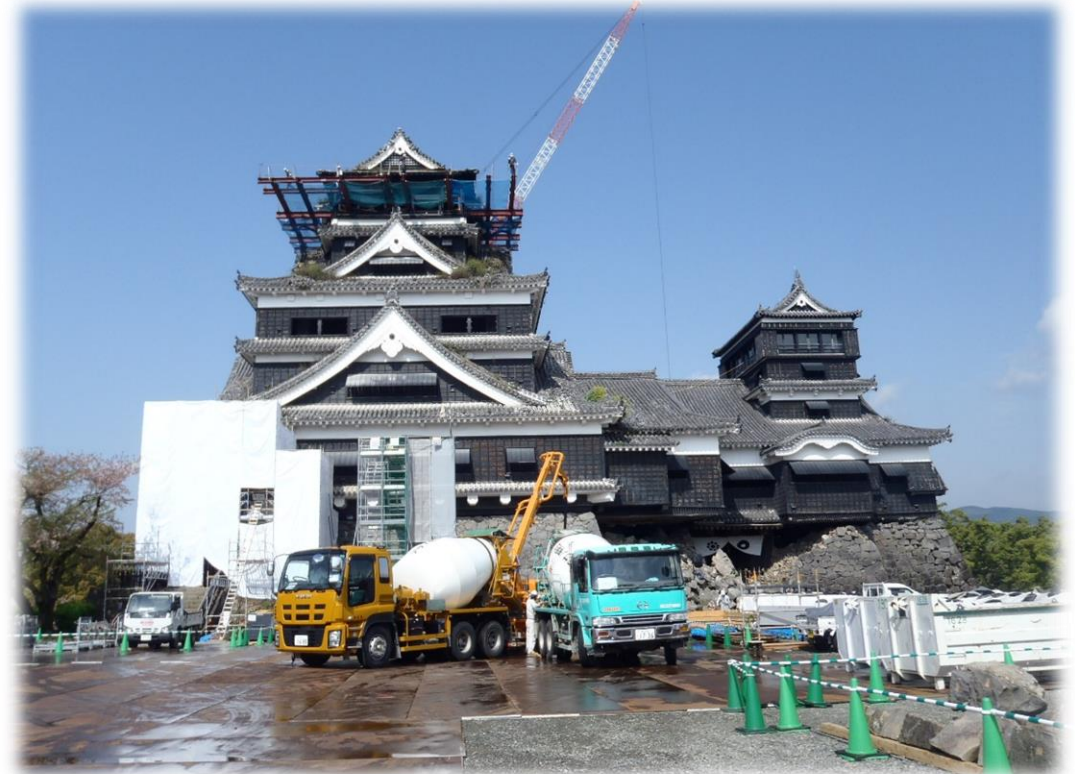
※ 熊本城災害復旧現場にて
